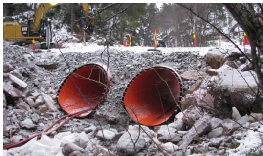
Vestre Musdalsbru – 2 nye kulverter
