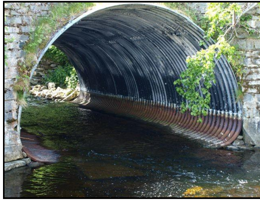
Figur 1 Tennelelva, korrugert stålør under Fv710
