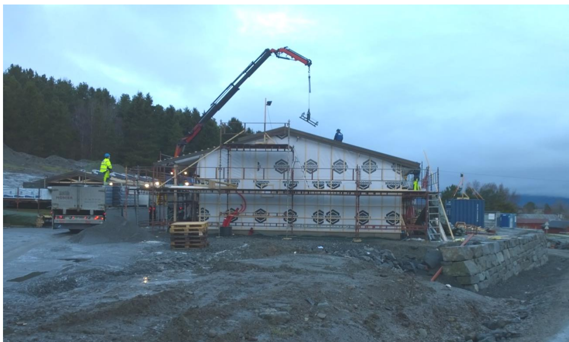
Omsorgsboliger med fellesareal Blekkan under oppføring
