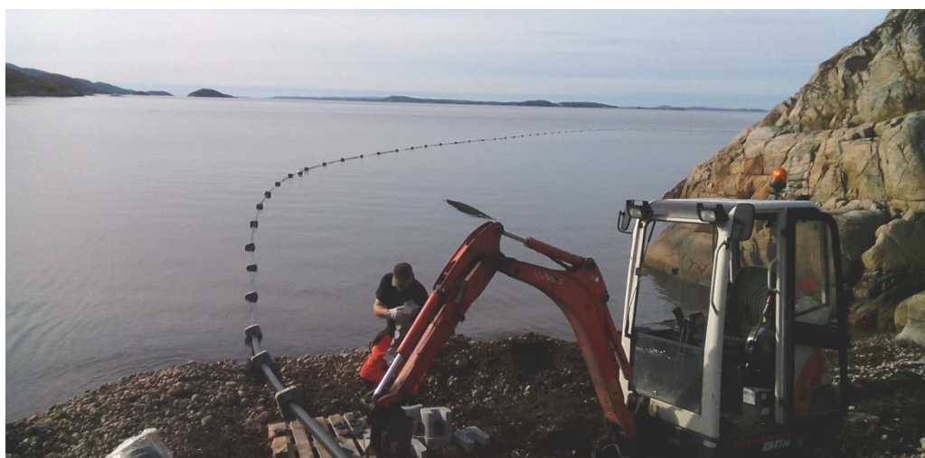
Utskifting av sjøledning mellom Værnes - Sletvik
