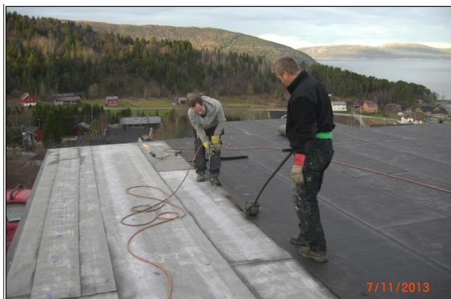
Taktekking på høydebassenget i Vollahaugen
