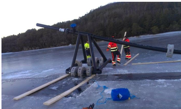
Utbedring av havari på vannforsyningen i Ytre Agdenes
