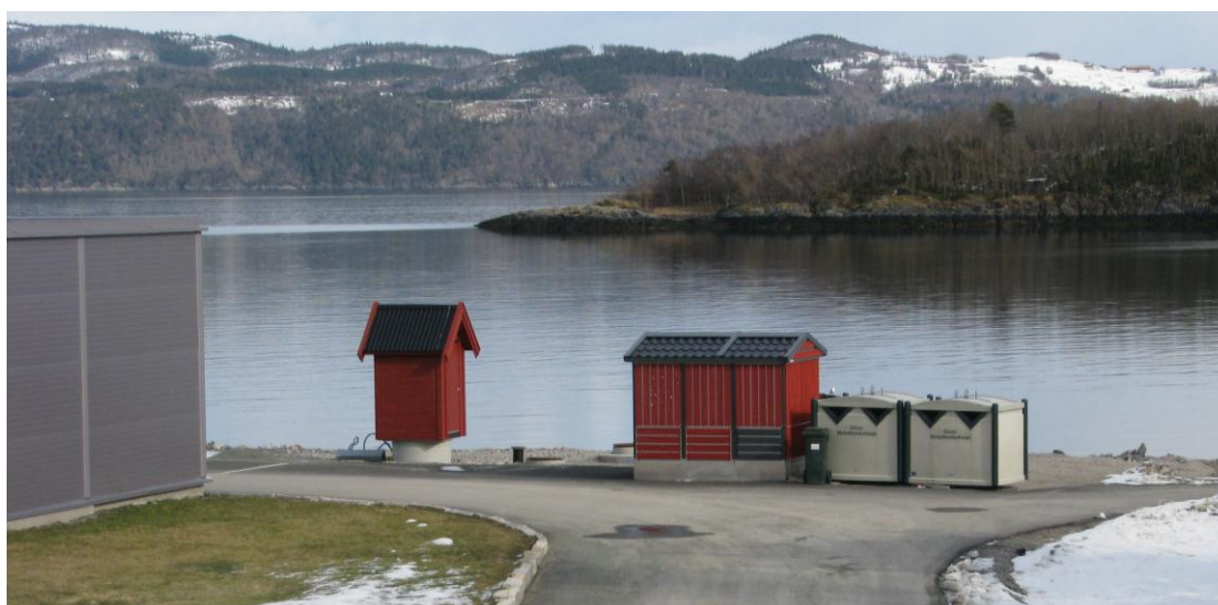
Ny pumpestasjon ved COOP Lensvik.
